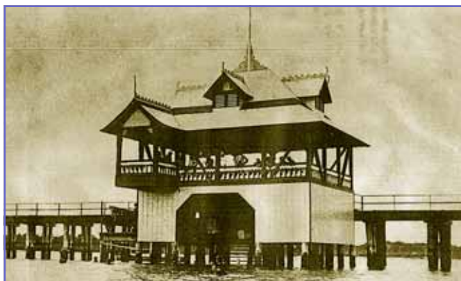
Stationsbyggnaden på järnvägspiren i St. Petersburg
